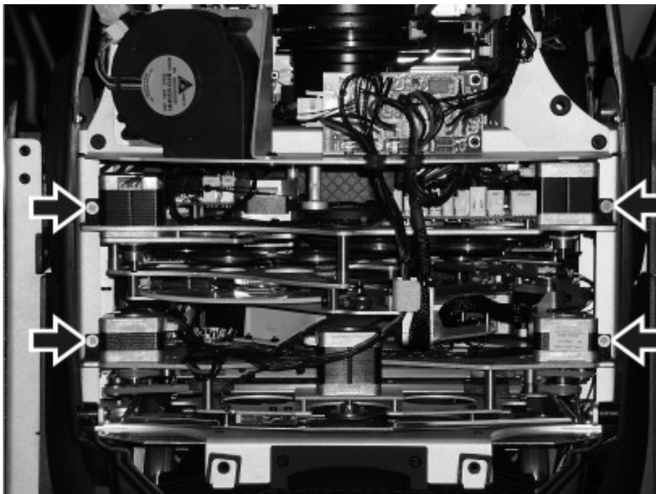
Bild 28: Befestigungsschrauben der Module
